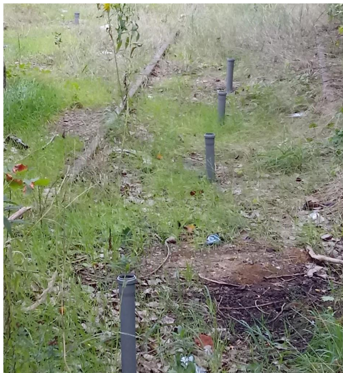
Rysunek 24. Widok zainstalowanych rur iniekcyjnych
