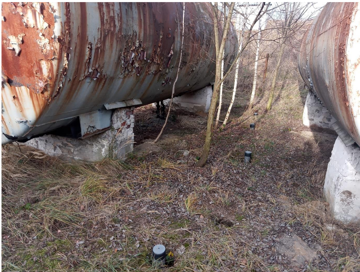
Rysunek 28. Widok terenu 2 przygotowanego do iniekcji dogłębowych
