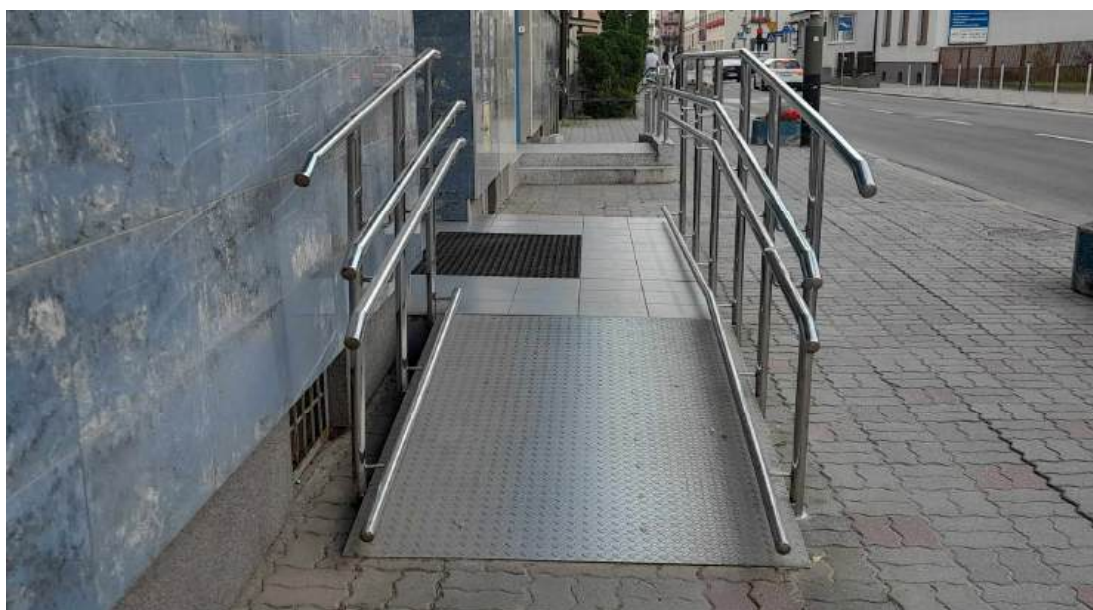
Rysunek 29. Pochylnia dla wózków inwalidzkich zamontowana przed jednym z urzędów w Rzeszowie
