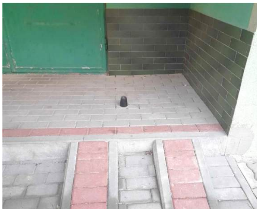
Rysunek 34. Podjazd dla wózków inwalidzkich zamontowany na jednym z osiedli mieszkaniowych w Rzeszowie
