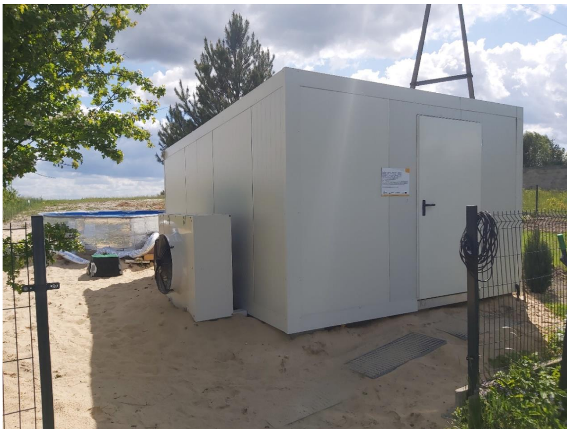
Rys. 16 Stanowisko – górne źródło energii, odbiór ciepła w postaci otwartego zbiornika zewnętrznego, oraz opcjonalnie wymiennik powietrzny. Zdjęcie przedstawia również pomieszczenie stanowiska badawczego.
