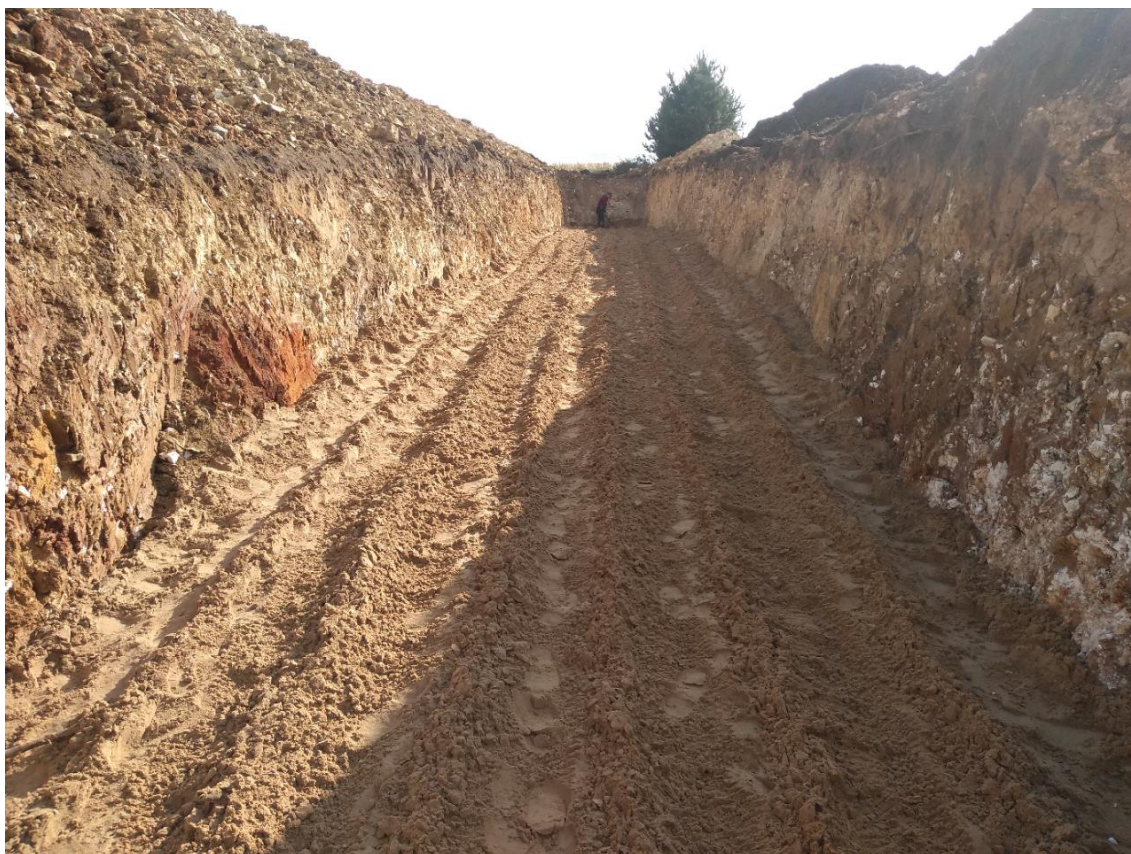
Rys. 15 Stanowisko badawcze - wymienniki gruntowe, dolne źródło energii
