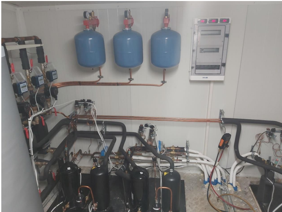
Rys. 17 Instalacja układów sprężarkowych wraz z instalacją hydrauliczną górnego źródła energii.
