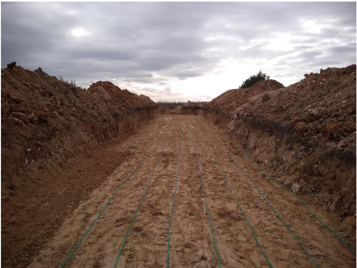
Rys. 4 Wymiennik gruntowy typu bezpośrednio odparowanie/woda.
