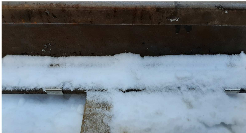
Rys. 5.31. Wytapianie śniegu w układzie EOR po czasie 30 sekund. Źródło: opracowanie własne.
