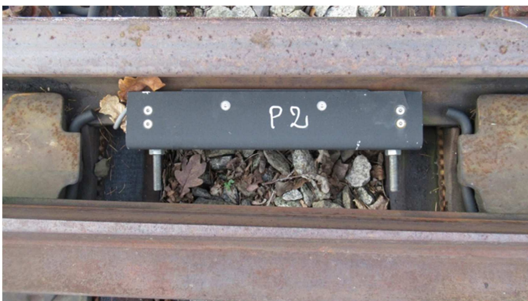
Rys. 2.12. Radiator IOR pomiędzy iglicą a opornicą. Źródło: opracowanie własne.
