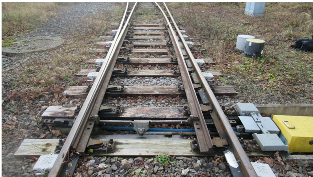
Rys. 2.11. Zabudowane elementy elektrycznego indukcyjnego ogrzewania rozjazdów – radiatory z układami zasilania i sterwania. Źródło: opracowanie własne.
