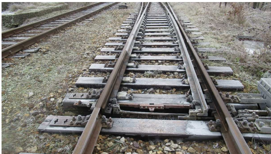
Rys. 6.2. Urządzenie EOR w trakcie nagrzewania elementów rozjazdu. Źródło: opracowanie własne.
