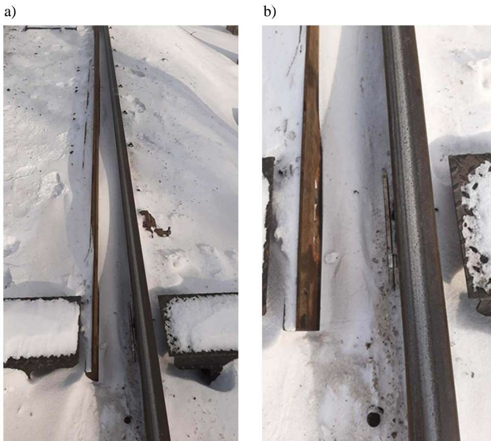
Rys. 1.2. Zablokowany rozjazd kolejowy po burzy śnieżnej przez nagromadzony śnieg pomiędzy iglicą a opornicą (a,b). Źródło: opracowanie własne.
