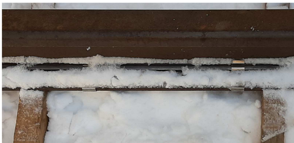
Rys. 5.32. Wytapianie śniegu w układzie EOR po czasie 7 minut. Źródło: opracowanie własne.
