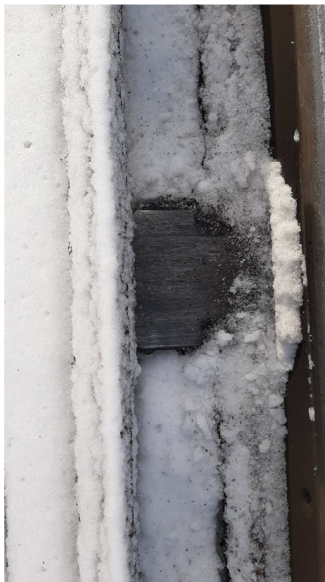
Rys. 1.1. Zablokowany rozjazd kolejowy przez śnieg nagromadzony pomiędzy iglicą a opornicą (a,b). Źródło: opracowanie własne.
