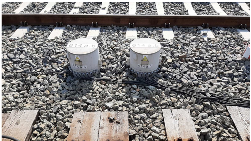
Rys. 2.3. Zabudowane skrzynie transformatorowe z transformatorami separacyjnymi. Źródło: [20].
