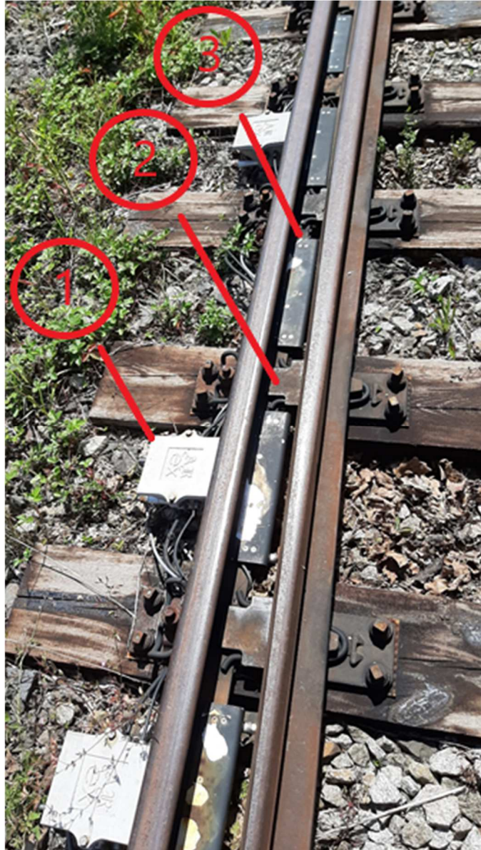
Rys. 2.18. Zabudowane radiatory układu IOR pomiędzy iglicą a opornicą z układem zasilania i sterowania (1 - układ zasilania i sterowania, 2 - siodełko, 3 - radiator IOR). Źródło: opracowanie własne
