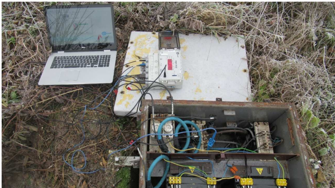
Rys. 6.1. Badanie jakości energii elektrycznej urządzeń EOR analizatorem typu SONEL PQM 701Z. Źródło: opracowanie własne.
