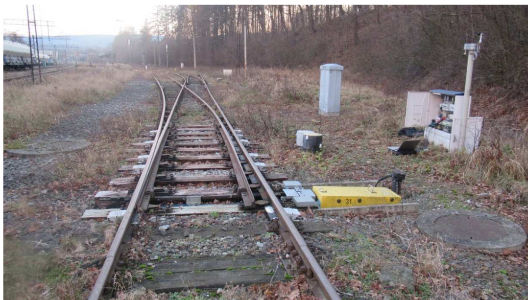
Rys. 6.7. Zabudowane innowacyjne urządzenie IOR w rozjeździe kolejowym. Źródło: opracowanie własne.
